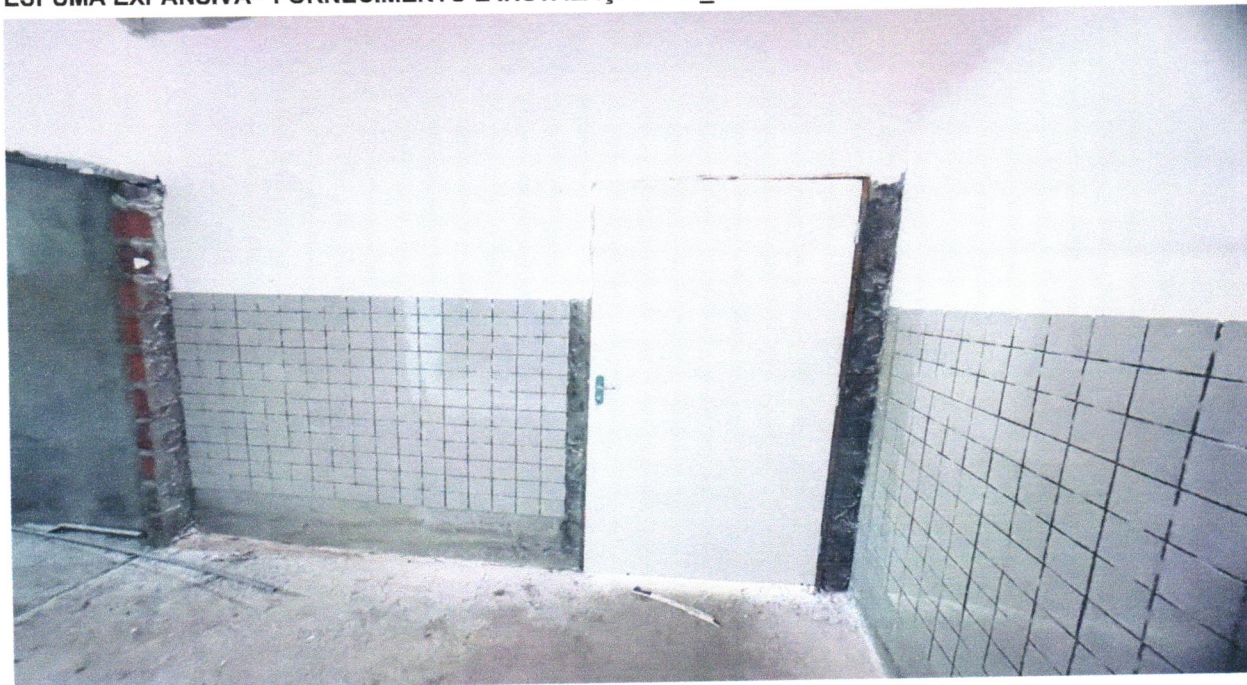
FOTO 02 - KIT DE PORTA-PRONTA DE MADEIRA EM ACABAMENTO MELAMÍNICO BRANCO, FOLHA LEVE OU MÉDIA, 80X210CM, EXCLUSIVE FECHADURA, FIXAÇÃO COM PREENCHIMENTO PARCIAL DE ESPUMA EXPANSIVA - FORNECIMENTO E INSTALAÇÃO. AF_12/2019
