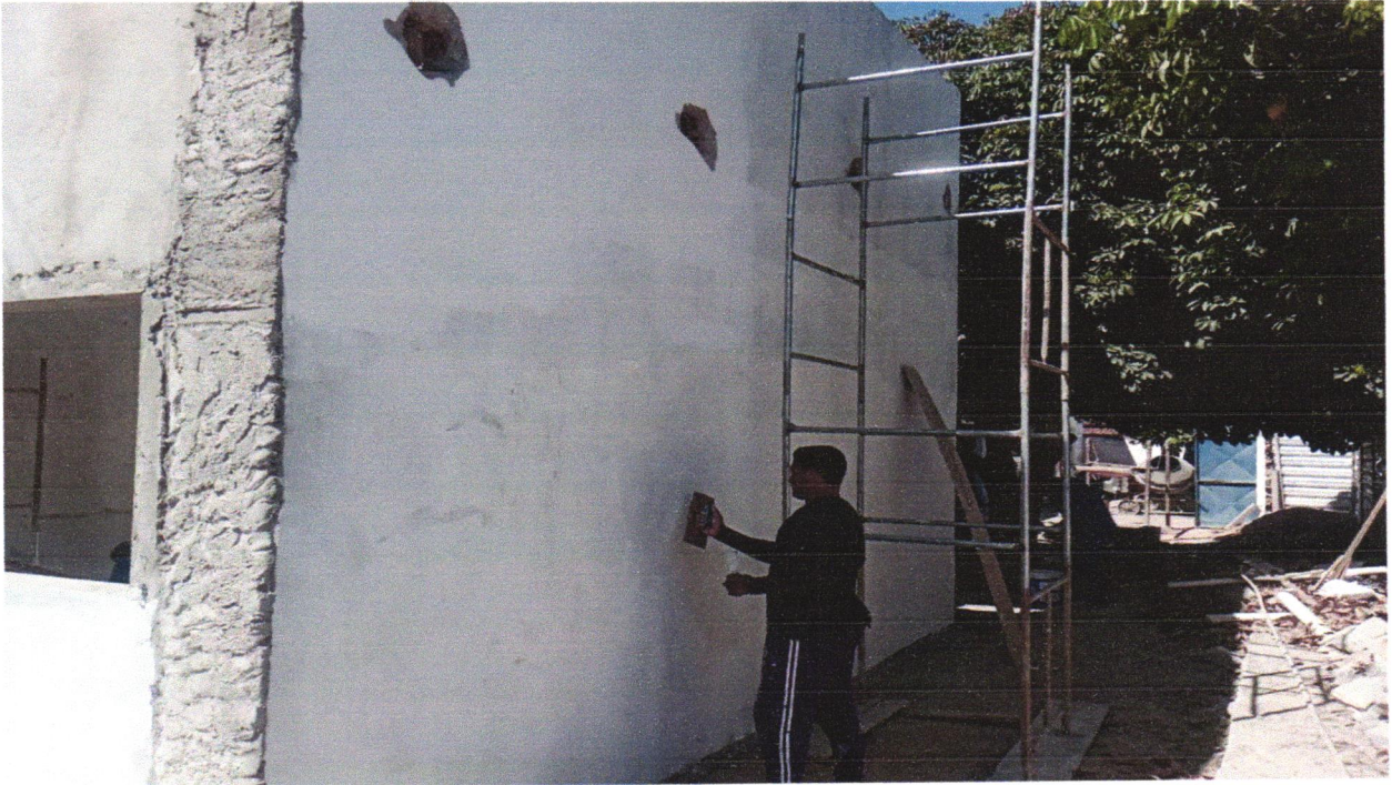
FOTO 18 - APLICAÇÃO E LIXAMENTO DE MASSA LÁTEX EM PAREDES, UMA DEMÃO. AF_06/2014
