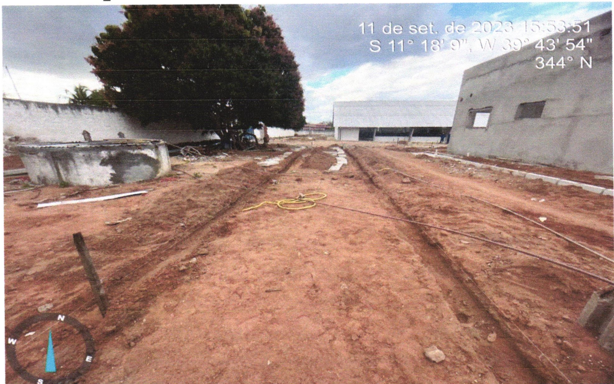
FOTO 22 - ATERRO MANUAL DE VALAS COM AREIA PARA ATERRO E COMPACTAÇÃO MECANIZADA. AF_05/2016"
