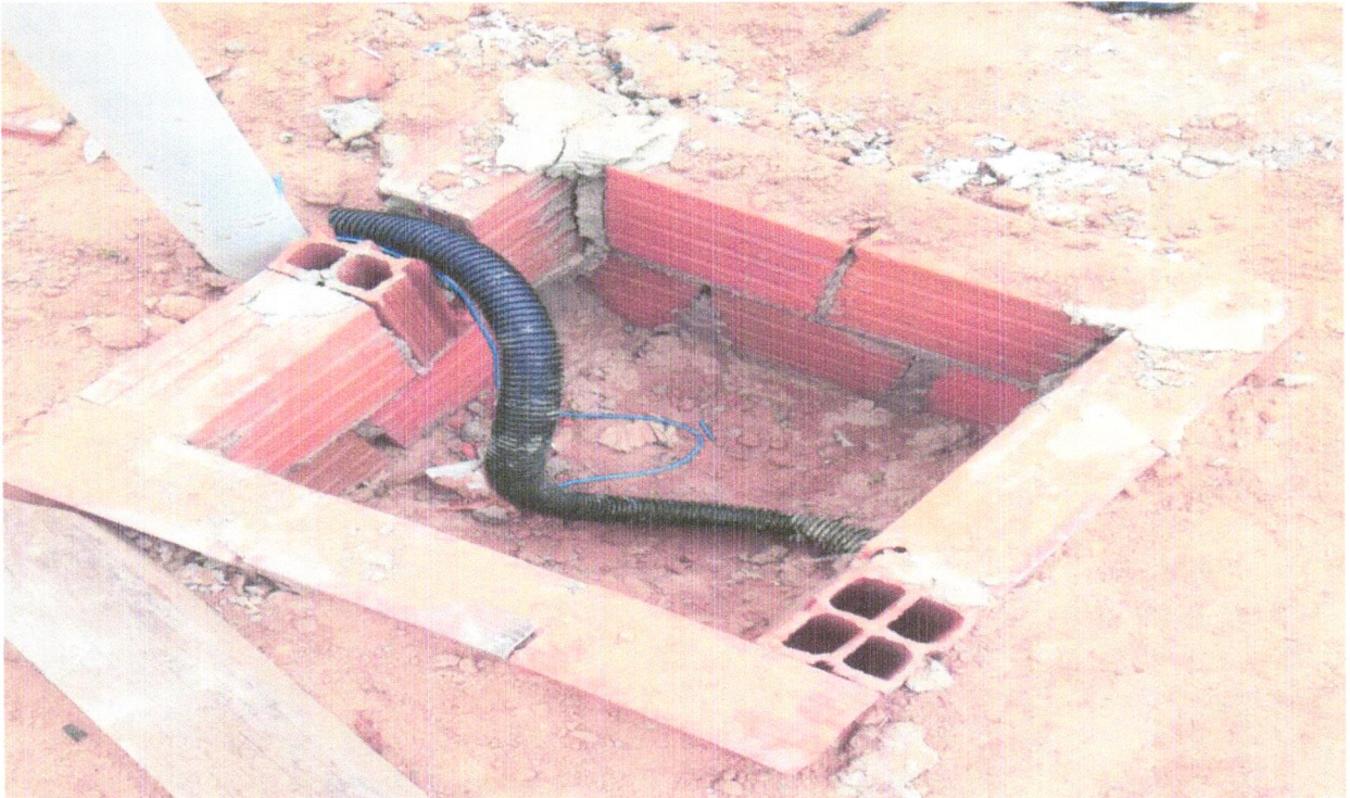
FOTO 32 - ELETRODUTO FLEXÍVEL CORRUGADO, PVC, DN 32 MM (1"), PARA CIRCUITOS TERMINAIS, INSTALADO EM FORRO - FORNECIMENTO E INSTALAÇÃO. AF_12/2015
