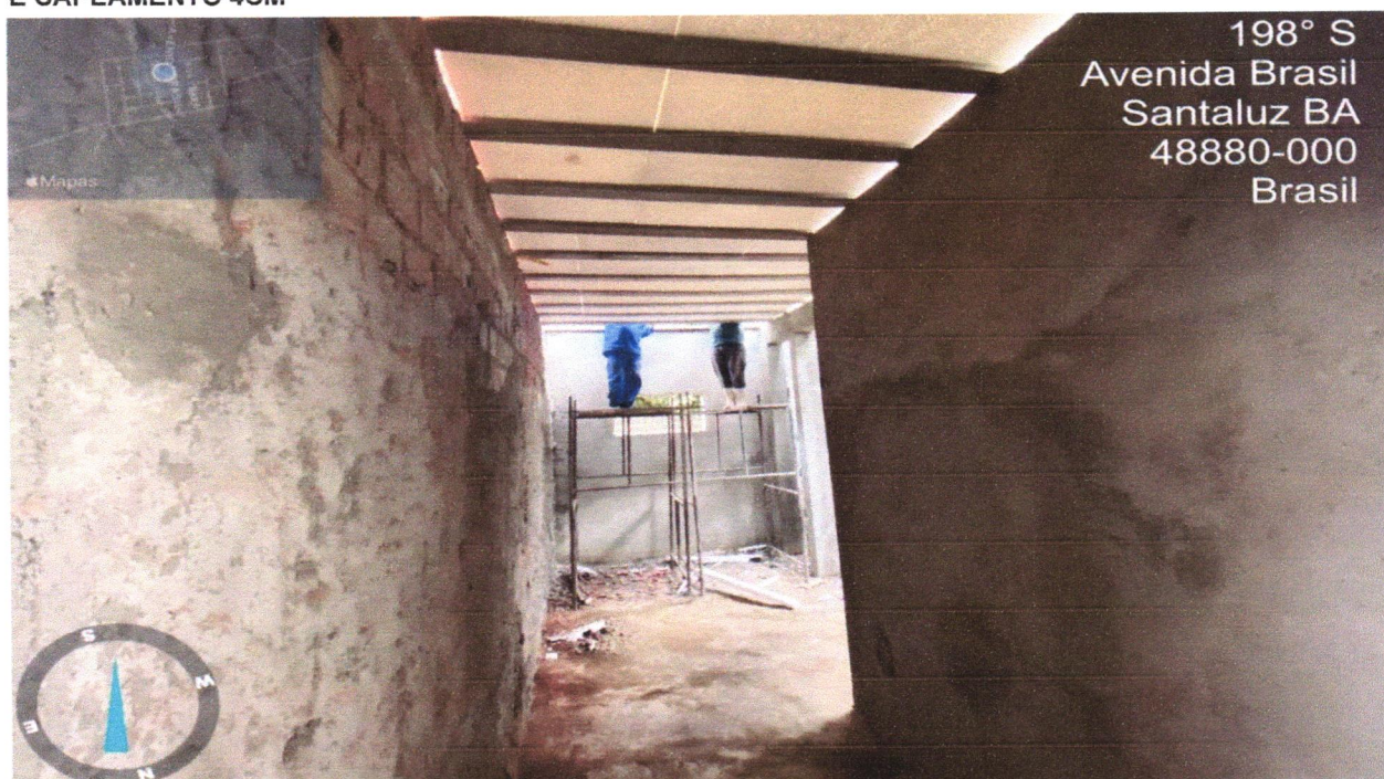
FOTO 20 - LAJE PRÉ-FABRICADA TRELIÇADA COM VIGOTA DUPLA PARA PISO, INTEREIXO 38CM, H=12CM, ENCHIMENTO EM BLOCO CERÂMICO H=8CM, INCLUSIVE ESCORAMENTO EM MADEIRA E CAPEAMENTO 4CM
