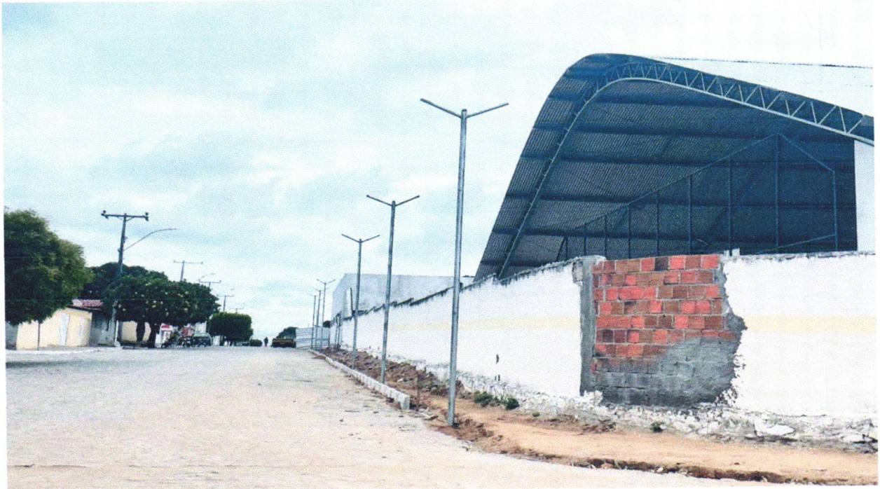
FOTO 26 - POSTE DE AÇO GALVANIZADO CÔNICO CONTÍNO RETO, DIÂMETRO SUPERIOR 60MM, DIÂMETRO DA BASE 115MM, ALTURA TOTAL 5M, CONIPOST REF. SÉRIE 0005/CLASSE 60 DA CONIPOST OU SIMILAR
