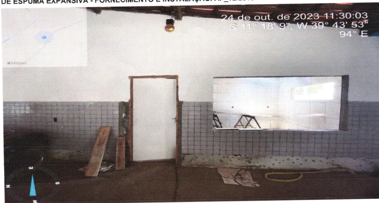
FOTO 02 - KIT DE PORTA-PRONTA DE MADEIRA EM ACABAMENTO MELAMÍNICO BRANCO, FOLHA LEVE OU MÉDIA, 80X210CM, EXCLUSIVE FECHADURA, FIXAÇÃO COM PREENCHIMENTO PARCIAL DE ESPUMA EXPANSIVA - FORNECIMENTO E INSTALAÇÃO. AF_12/2019
