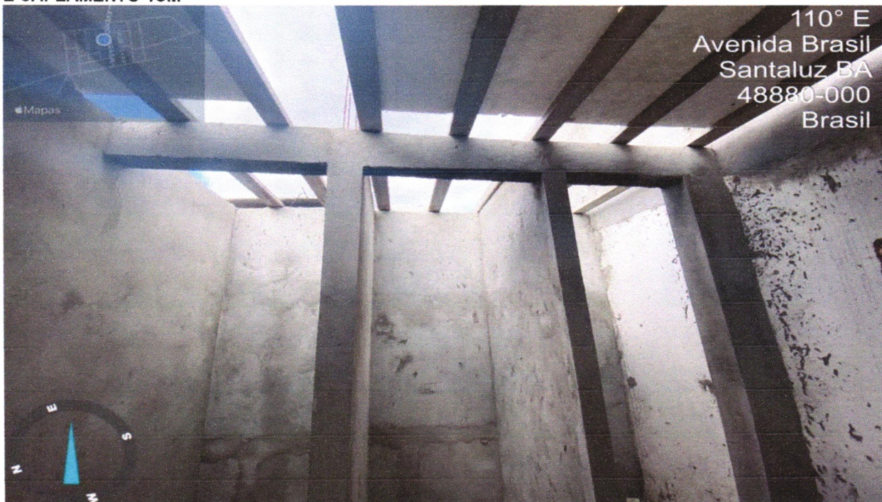
FOTO 20 - LAJE PRÉ-FABRICADA TRELIÇADA COM VIGOTA DUPLA PARA PISO, INTEREIXO 38CM, H=12CM, ENCHIMENTO EM BLOCO CERÂMICO H=8CM, INCLUSIVE ESCORAMENTO EM MADEIRA E CAPEAMENTO 4CM
