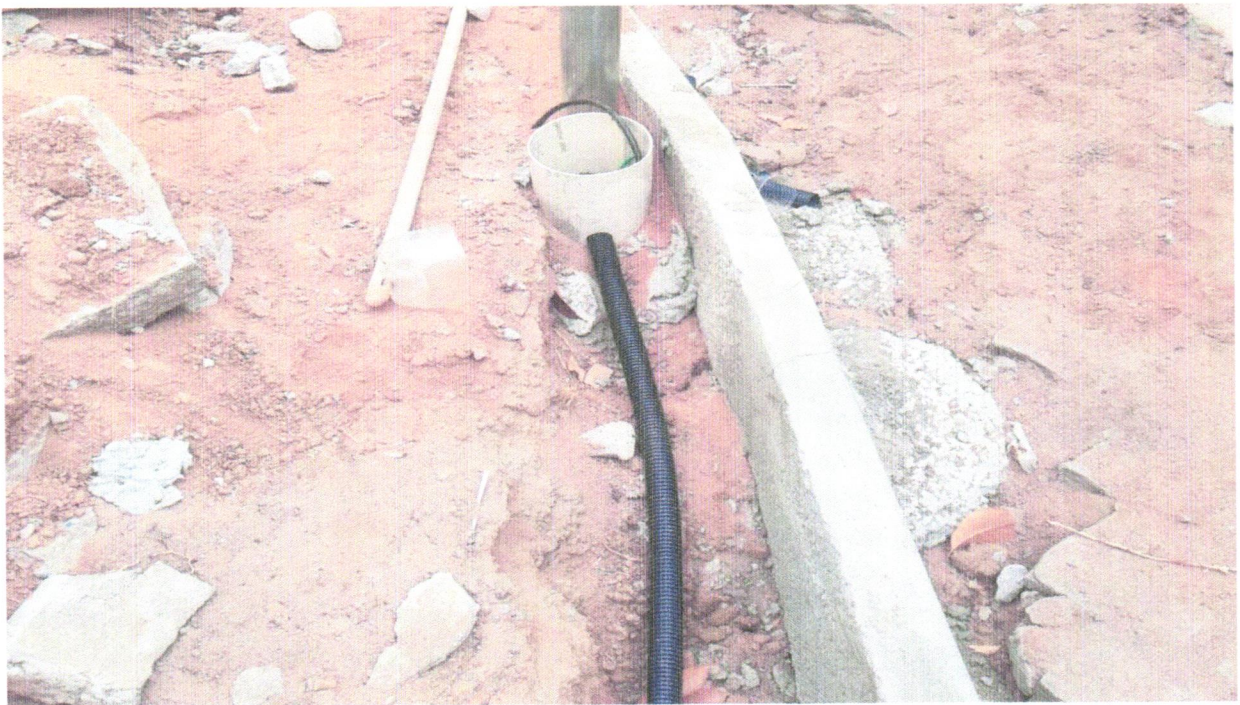
FOTO 32 - ELETRODUTO FLEXÍVEL CORRUGADO, PVC, DN 32 MM (1"), PARA CIRCUITOS TERMINAIS, INSTALADO EM FORRO - FORNECIMENTO E INSTALAÇÃO. AF_12/2015
